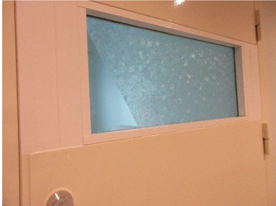
Potilashuoneen oven ikkuna
